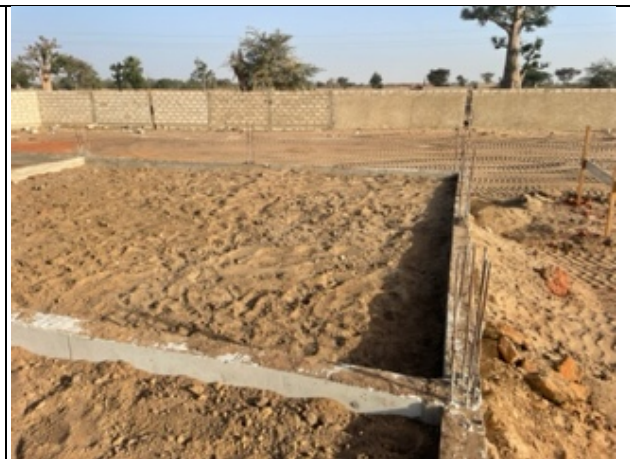
Béton de fondation et remblai contre fondation
