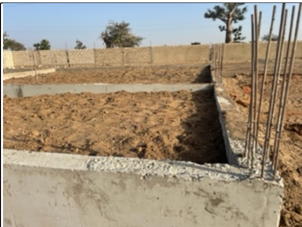
Béton de fondation et remblai contre fondation
