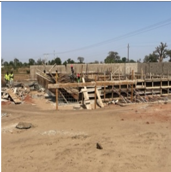
Coulage du voile de la poutre renversée
