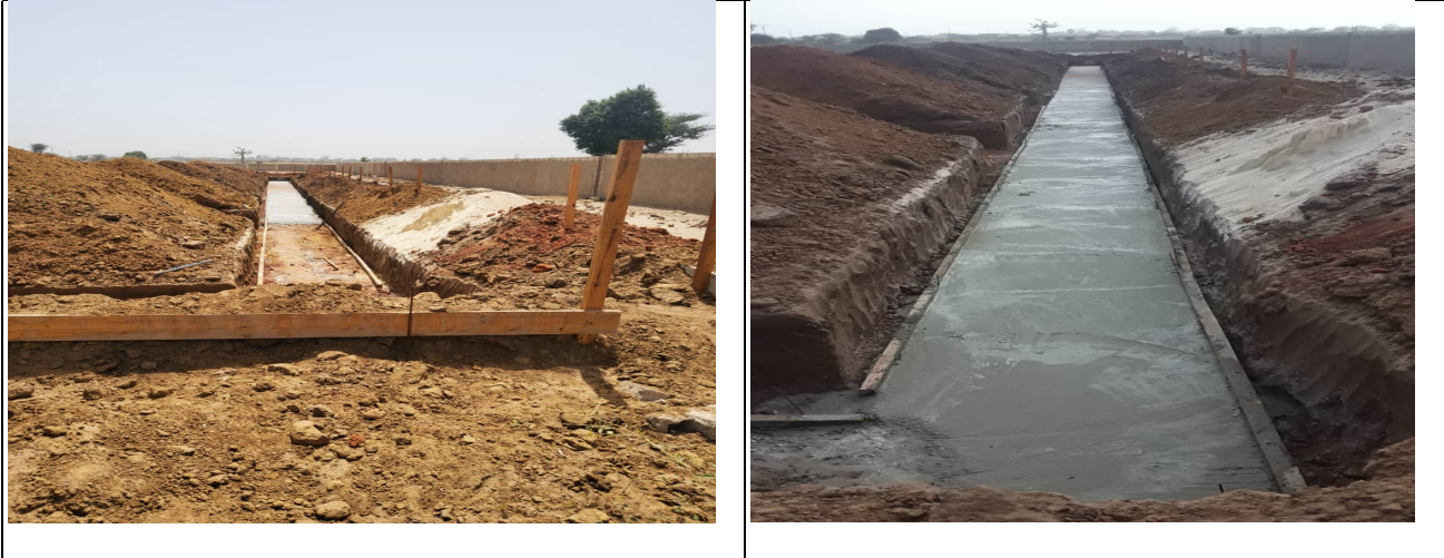
Compactage et réalisation de la couche de béton de propreté pour le bâtiment préscolaire/administration
