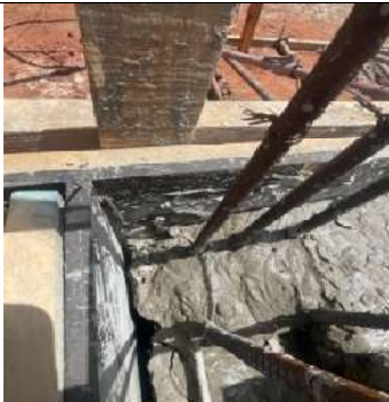
Coulage du voile de la poutre renversée
