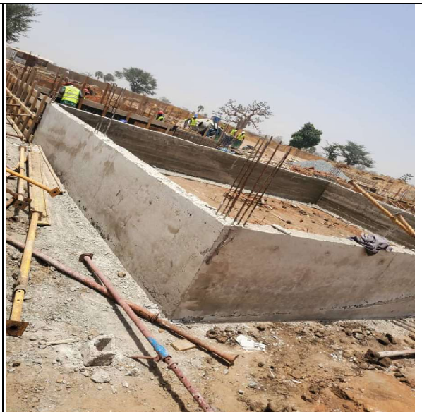
Coulage du voile de la poutre renversée
