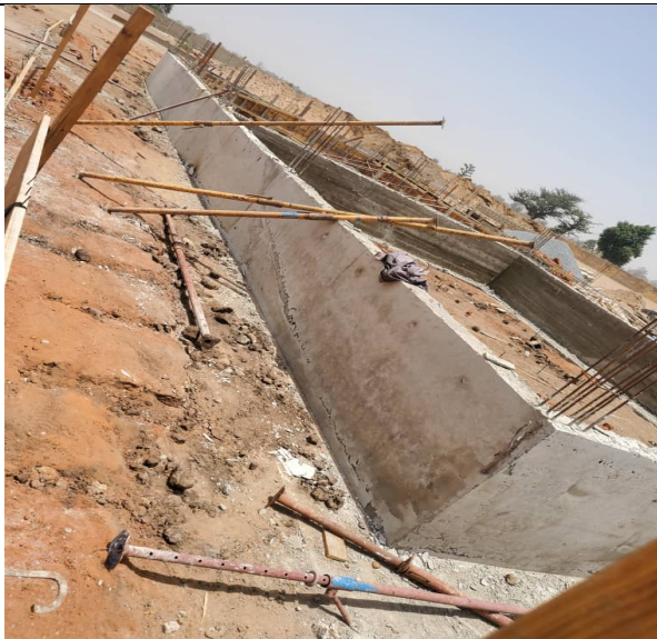
Coulage du voile de la poutre renversée
