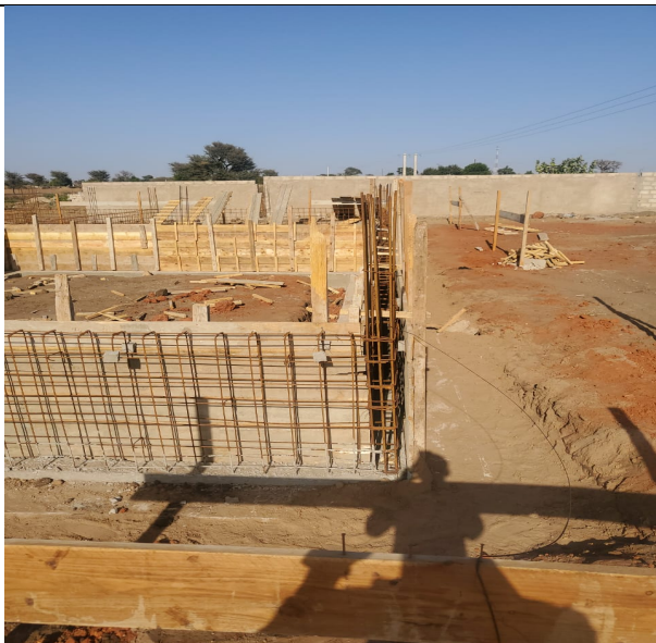
Coffrage du voile de la poutre renversée
