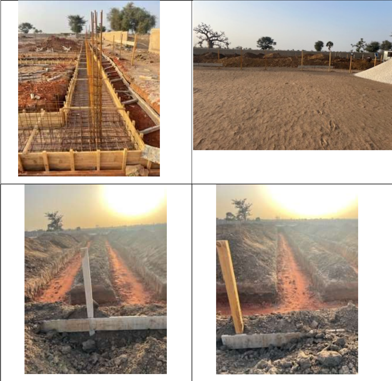
Fouilles tranchés longitudinaux sur bâtiment préscolaire et remblai en latérite
