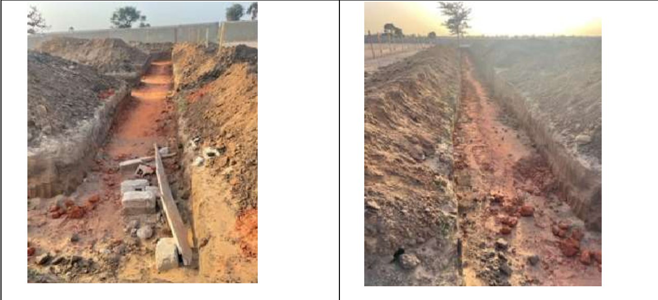
Fouilles tranchés longitudinaux sur bâtiment préscolaire et remblai en latérite
