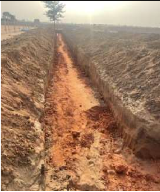
Fouilles sur bâtiment préscolaire et remblai en latérite
