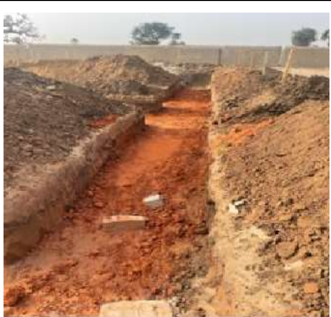
Fouilles sur bâtiment préscolaire et remblai en latérite
