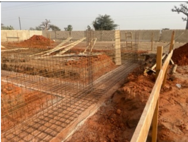
Ferrailage poutre renversée
