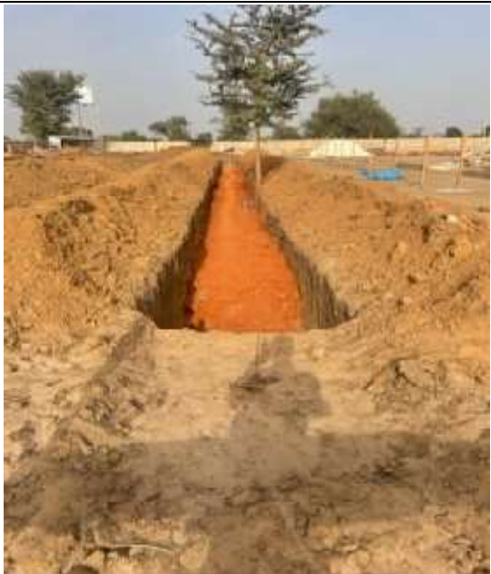
Fouilles sur bâtiment préscolaire et remblai en latérite
