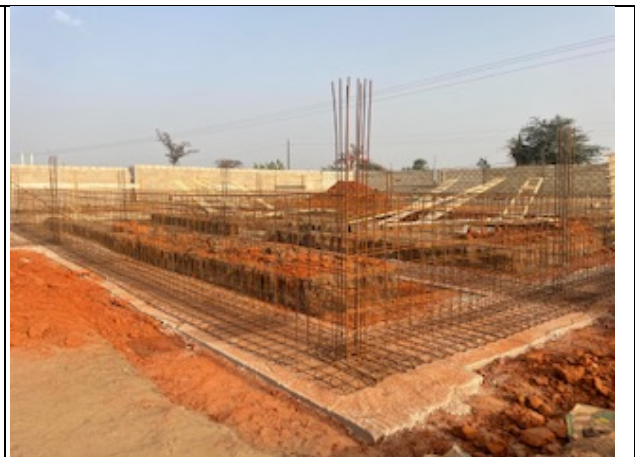
Ferrailage poutre renversée
