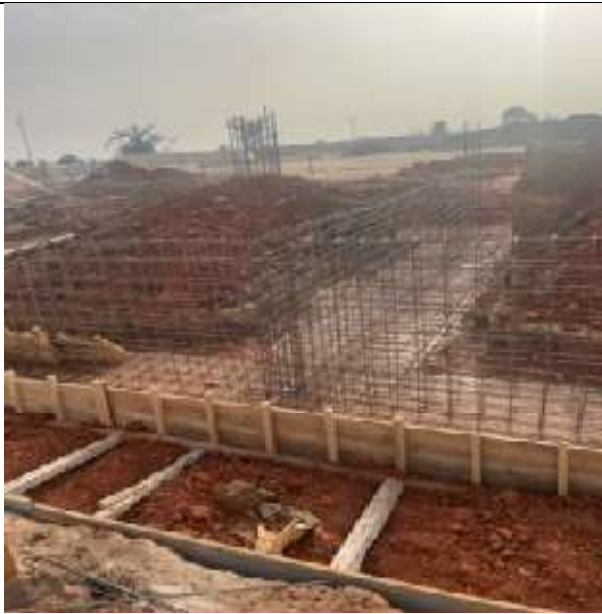
Ferrailage poutre renversée
